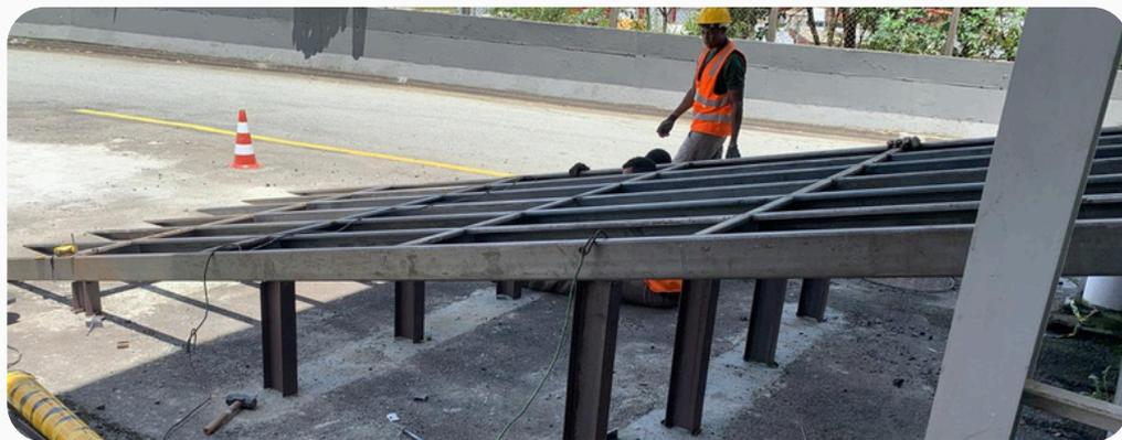
Fabricação de rampas metálicas
